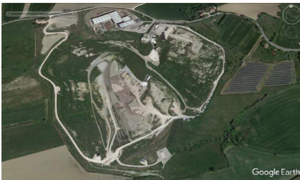
Panoramica impianto attraverso Google Earth (data di acquisizione immagine 04/2022)
