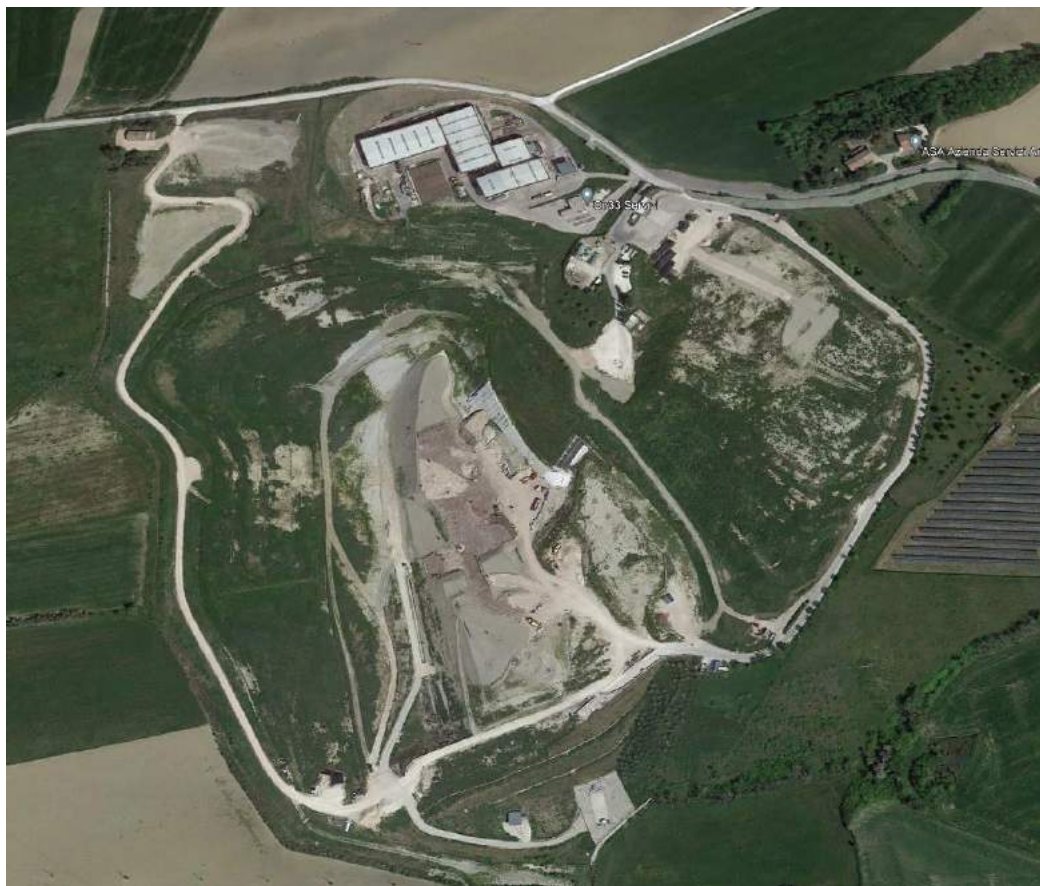
Foto panoramica impianto
