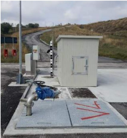
Visuale dell'asta graduata esterna per la misura del percolato dall'esterno
