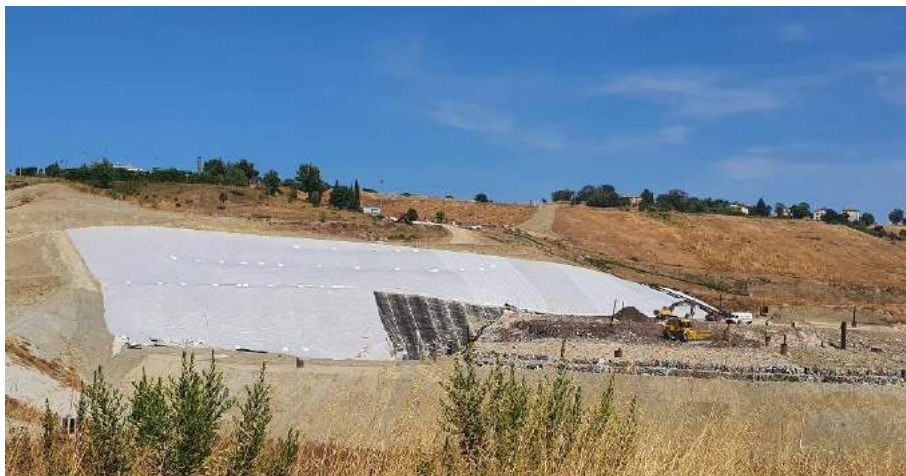
Copertura rifiuti con terreno e con materiale inerte riciclato
