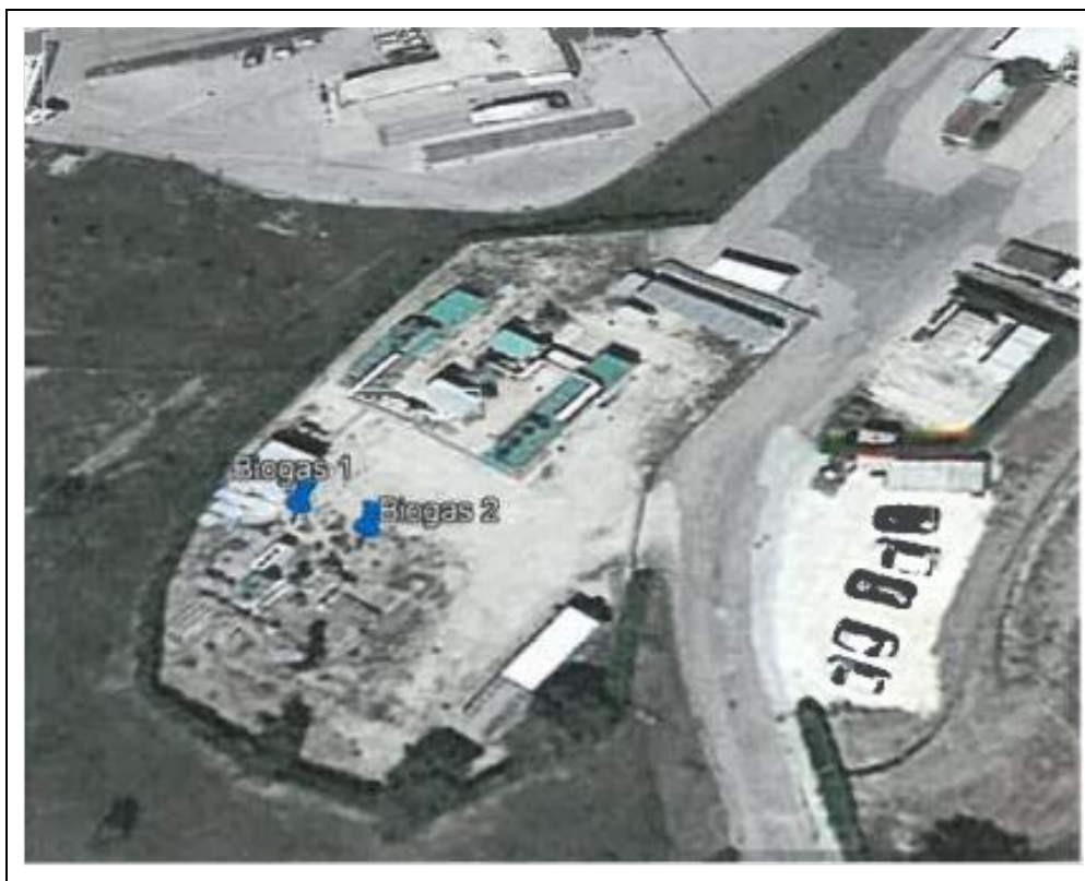
Figura 2 - Localizzazione dei punti di misura biogas
