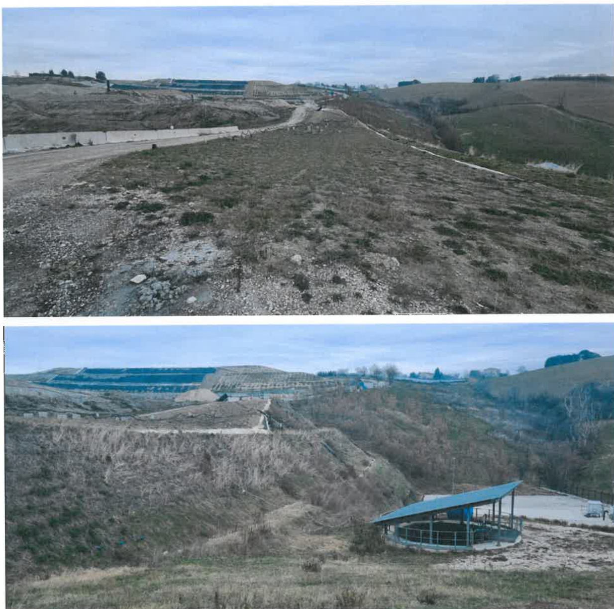
Figura 2 – Fotografie della sommità dell'argine e del fronte di valle prese nel sopralluogo del 24-1-2024
