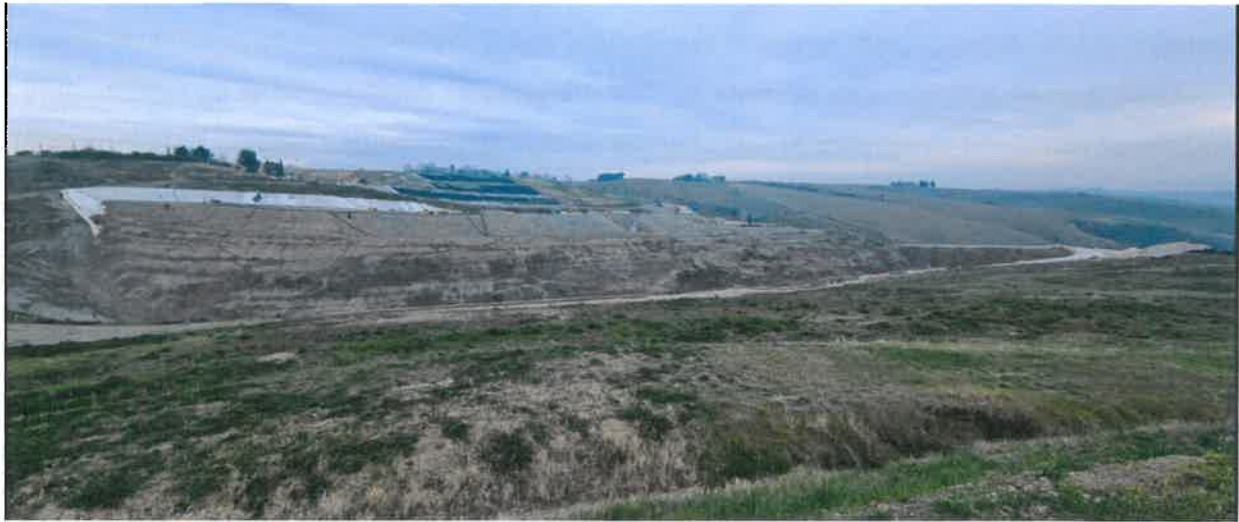
Figura 3 – Fotografia della zona di abbancamento dei rifiuti (l'argine è sulla destra, 24-1-2024)
